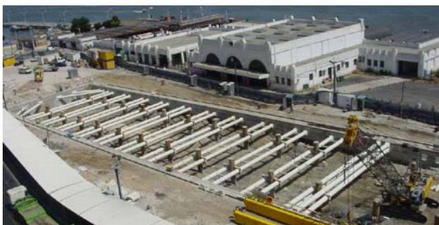
*Vista geral da Estação do Terreiro do Paço com a obra em execução (fase de entivação das paredes de contorno).*
