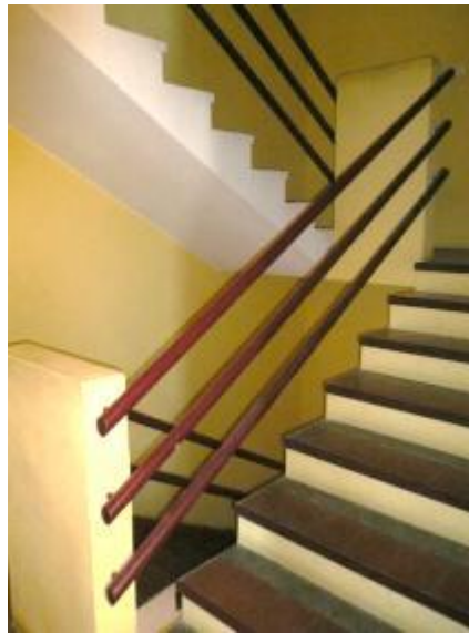
Figura 1 – Corrimão das escadas dos serviços comuns
