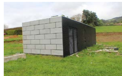
Posto de Transformação Particular
