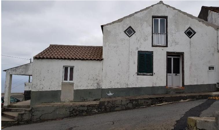
1 – Fornecimento e assentamento de telha e telhões (*artigos 6.2 e 6.3*), fecho de porta nos arrumos e fornecimento e montagem de janela em alumínio (trabalhos não previstos)
