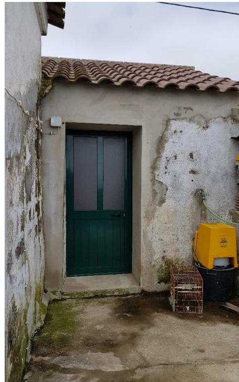
6 – Fornecimento e assentamento de telha e telhões (*artigos 6.2 e 6.3*) e fornecimento e montagem de porta em alumínio nos arrumos (trabalhos não previstos)
