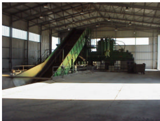
Figura n.º 7 – Vista geral sobre a unidade de compactação
