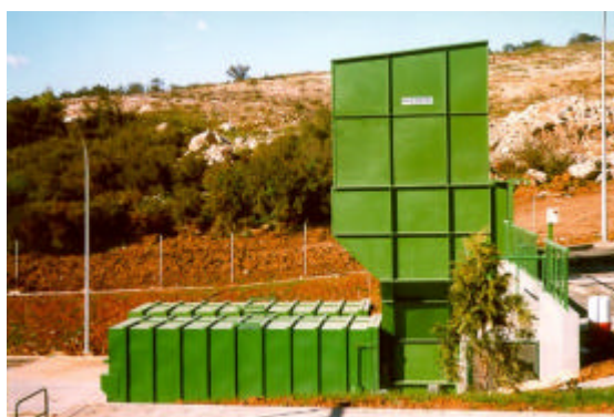
Figura n.º 3 - Estação de Transferência de Pombal
