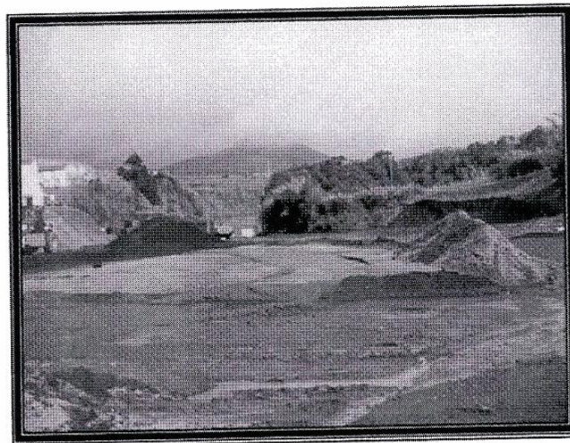
FASE INICIAL DO ATERRO – ÁREA DO POLIDESPORTIVO
