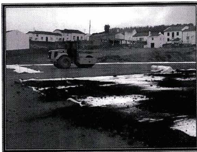
ATERRO E COMPACTAÇÃO – PREPARAÇÃO PARA INÍCIO DE ATERRO C/BAGACINA (FASE FINAL)
