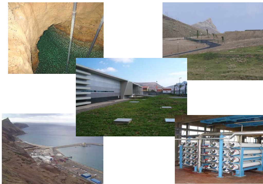
Figura 2 – Sistemas adutores da ilha do Porto Santo
