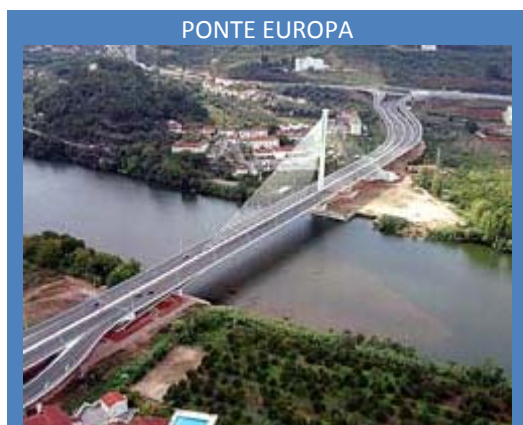
Vista área da Ponte Europa
