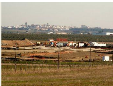
ILUSTRAÇÃO 4 - OBRAS DE CONSTRUÇÃO DO AEROPORTO DE BEJA
