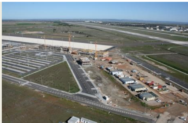
ILUSTRAÇÃO 3 - VISTA AÉREA DO AEROPORTO DE BEJA E RESPECTIVA PISTA, AO FUNDO A BA 11
