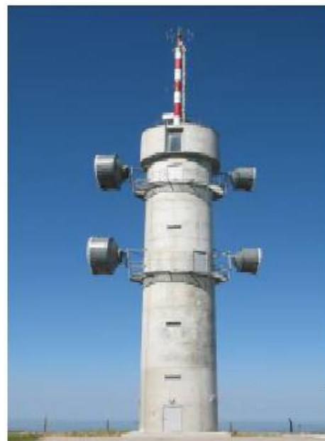
Figura 10 – Uma das torres de suporte do VTS
