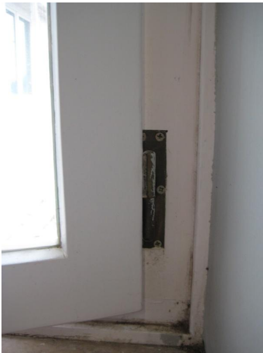
3- Aspeto da ferragem de manobra em janela de madeira recuperada (cf. Pontos 2.7.2.1 e 2.7.7.1).
