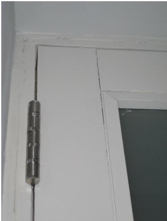
23 - Vãos interiores novos em madeira - fissuração nas juntas dos prumos, bites e pintura deficiente (cf. Ponto 2.7.4).
