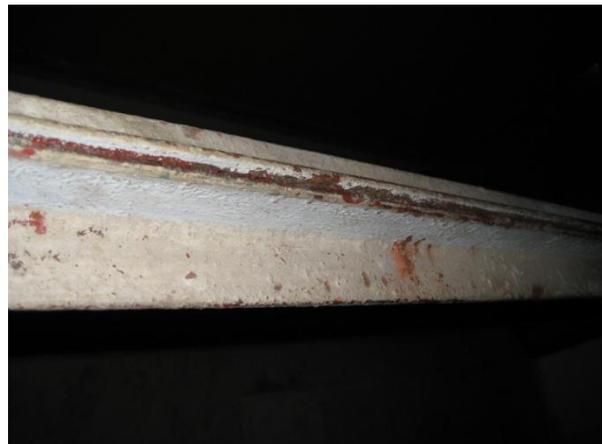
**28** - Oxidação prematura e pintura deficiente nos perfis da estrutura metálica do telhado do Liceu (cf. Ponto 2.7.4).
