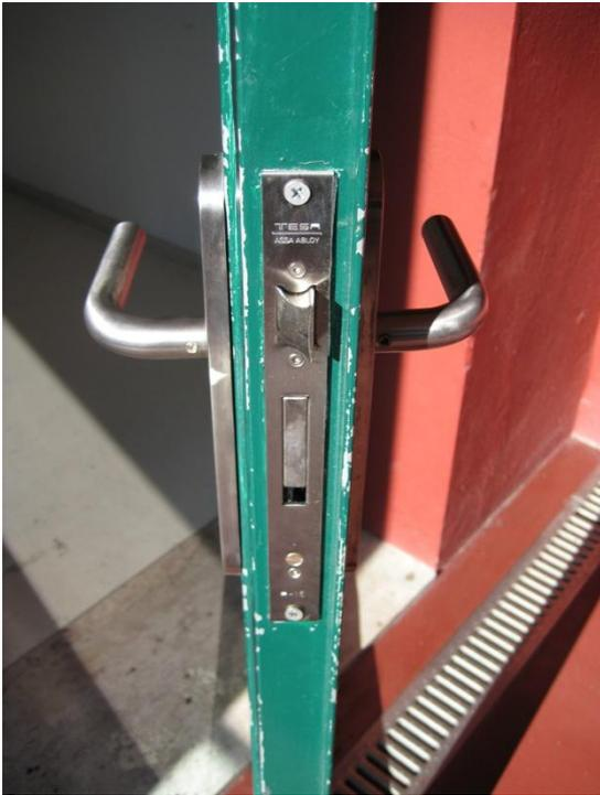
**29** - Vãos exteriores novos metálicos - destacamento da pintura nos aros das folhas de abrir (cf. Ponto 2.7.4).
