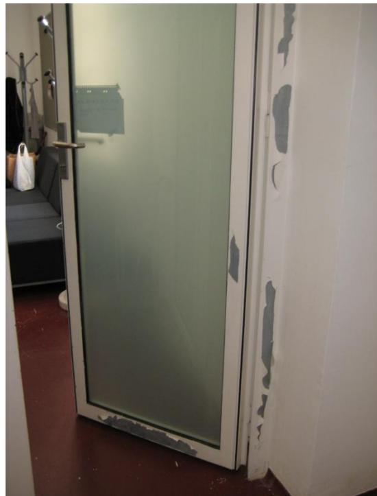
**32** - Vãos interiores novos metálicos - destacamento da pintura (exemplo 1) - cf. Ponto 2.7.4.
