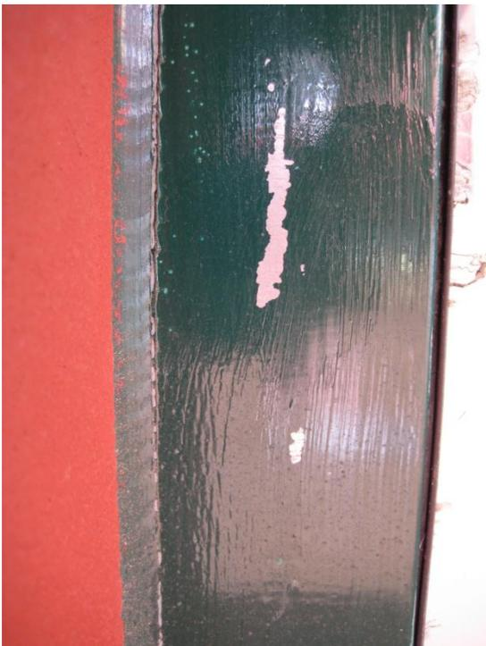
**31** - Vãos exteriores novos metálicos - destacamento da pintura dos aros e mau acabamento da superfície (cf. Ponto 2.7.4).
