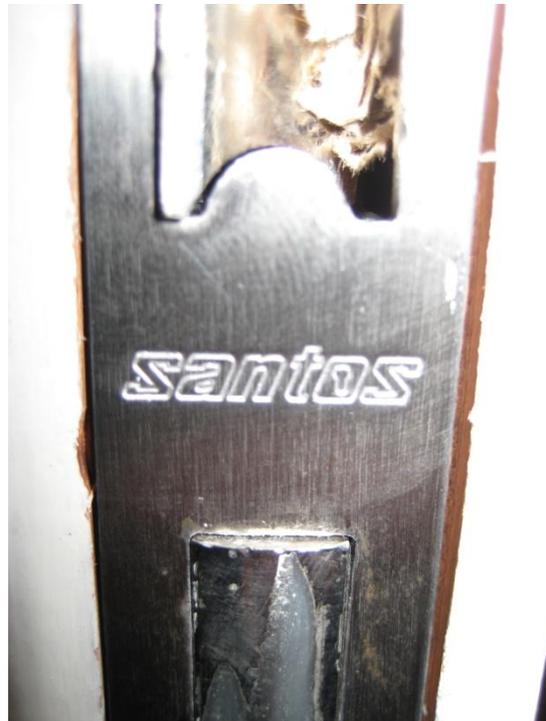
24 - Vãos interiores novos em madeira - acabamento sofrível das caixas das fechaduras (cf. Ponto 2.7.4).
