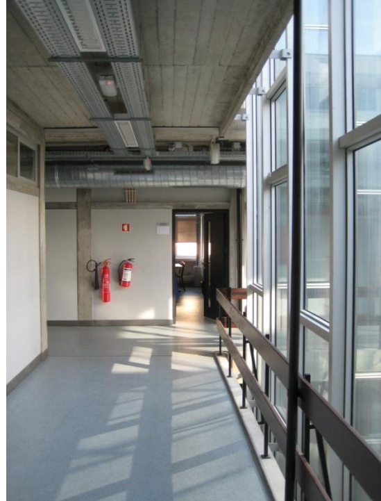
26 - Blocos A1, A2 e A3 - Circulação no piso 1.
