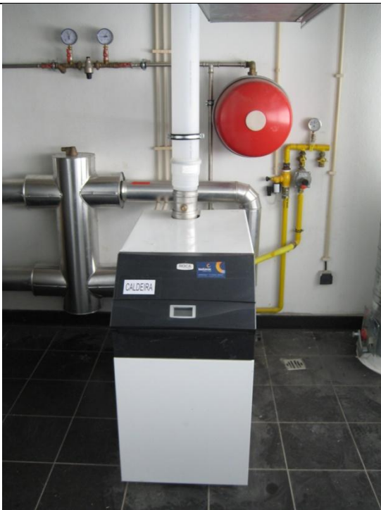
39 - Caldeira de chão em compartimento técnico.
