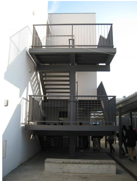
24 - Bloco A2 - Escadas exteriores de emergência.
