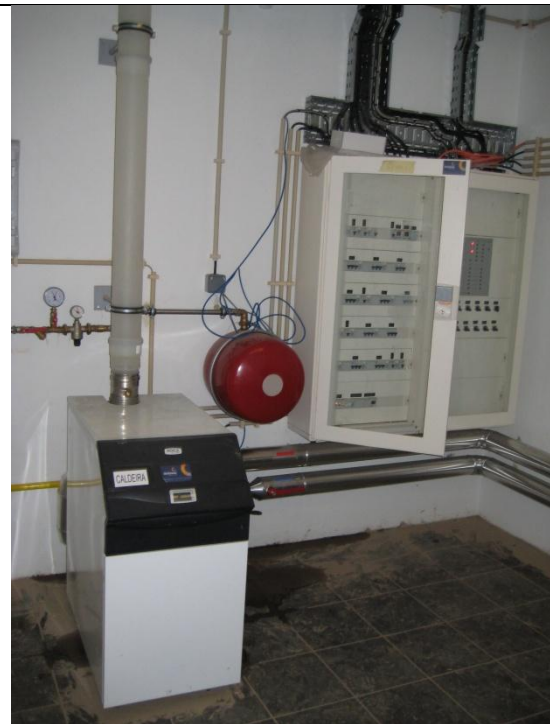
40 - Bloco A5 - Caldeira de chão na zona técnica.
