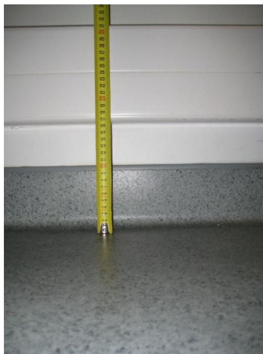
30 - Blocos A1, A2 e A3 - Pormenor do rodapé em vinílico e calha elétrica.
